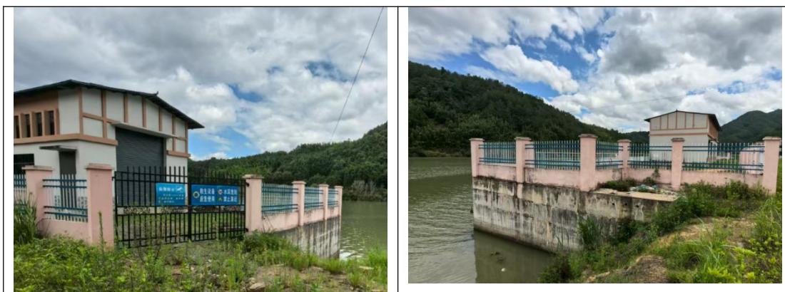
图2.3-1 取水泵站现状照片
