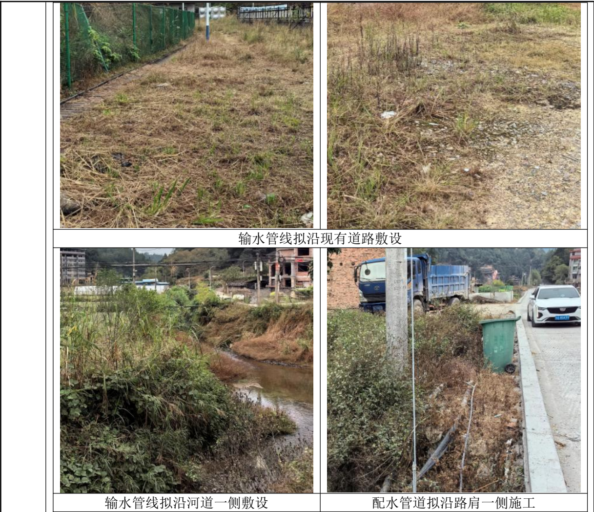
图 2.2-3 部分管道施工沿线现状图
