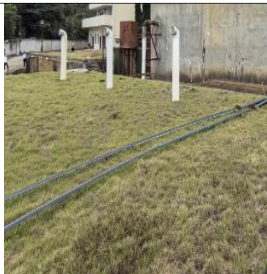
现状清水池（地下池）
