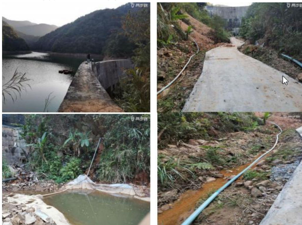
图 2.2-1 翁坑水库周边环境现状
