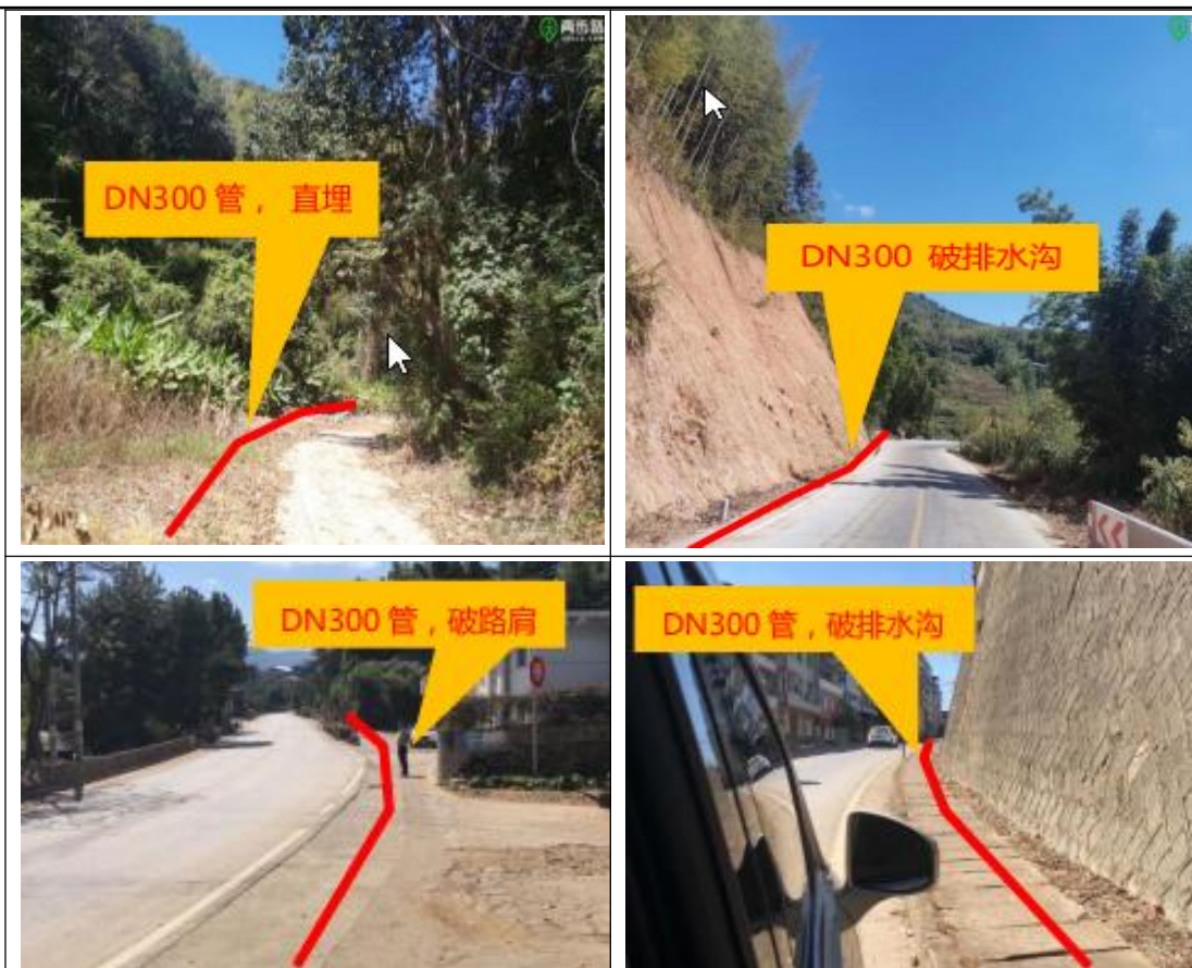
输水管道敷设路段现状图
