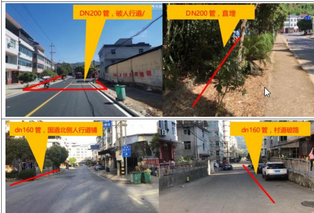
配水管道敷设路段现状图
