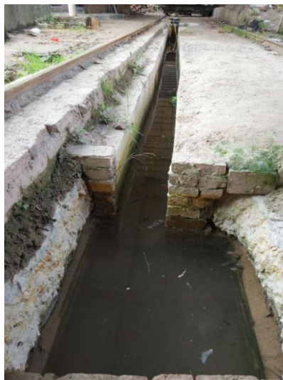
排水沟、沉沙池
